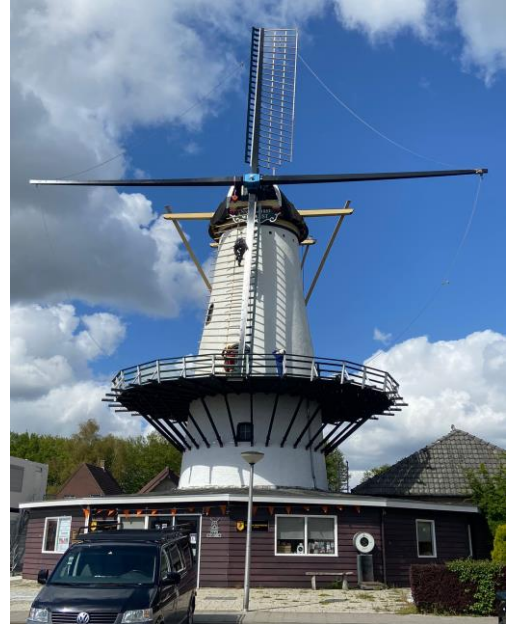
Foto links: De firma Tuk uit Klaaswaal brengt de roeden aan en op de foto rechts worden de roeden van het hekwerk voorzien.
