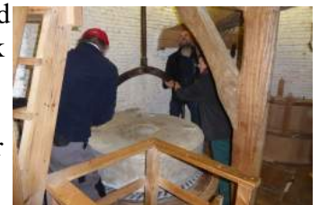
Het koppel blauwe stenen wordt opengelegd.
