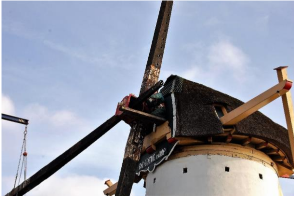
Verwijderen van de roeden van korenmol De Goede Hoop te Mijnsheerenland.
