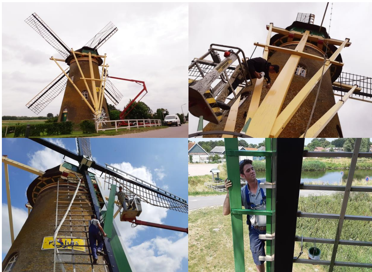
Impressie van de onderhoudswerkzaamheden in de zomer door Wim en Arie-Willem van der Wal
